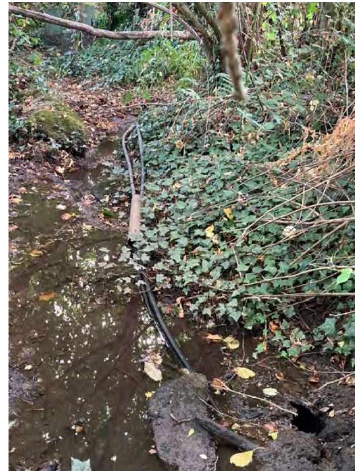
7 dérivation de l'eau vers la mare
